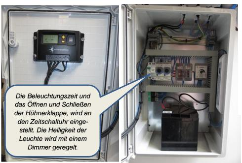
Schaltschrank mit Spannungsversorgung über eine Photovoltaikanlage 12V/150Wp.
